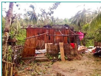
Dégâts causés par RAI
